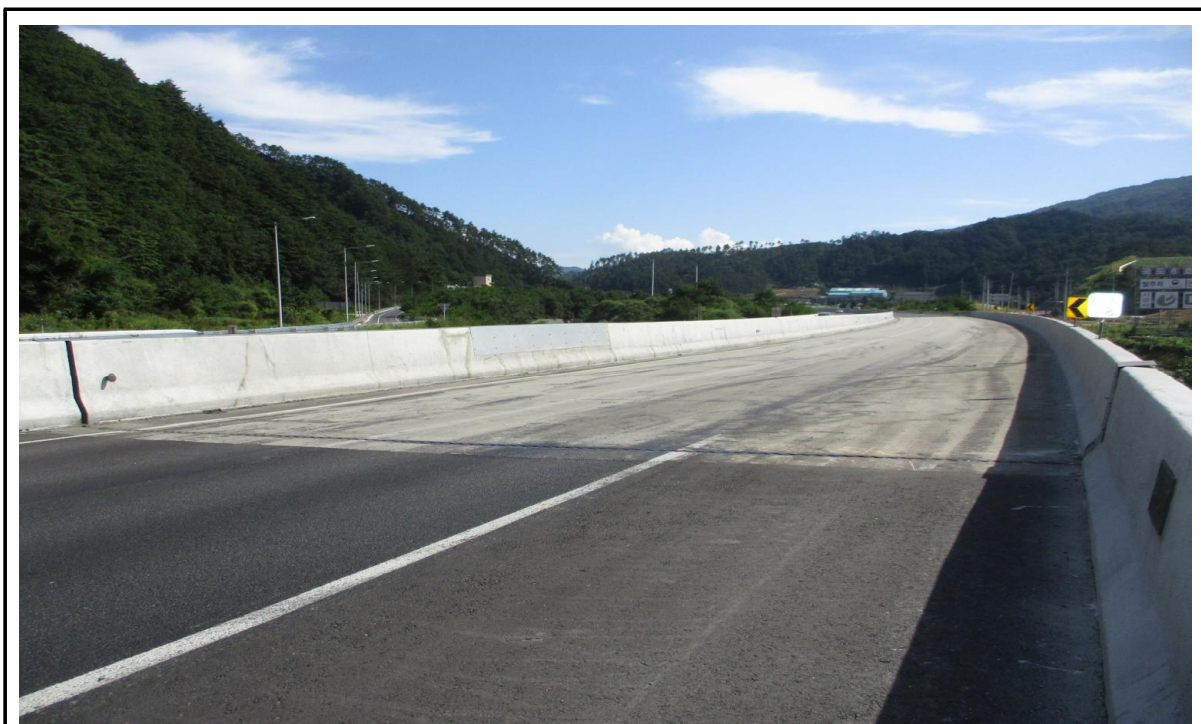
교량 상부 전경
