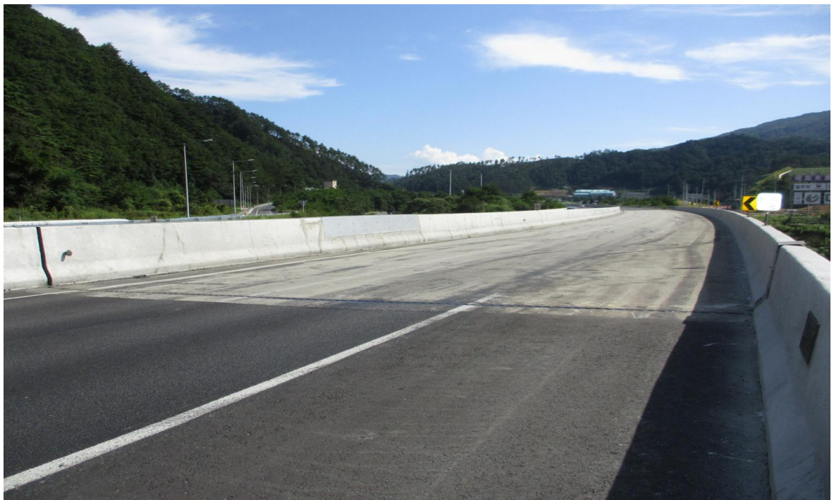
교량 상부 전경
